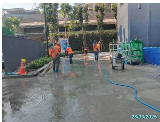
รูปที่ 3-8 คนงานฉีดพรมน้ำบริเวณพื้นที่ก่อสร้าง
